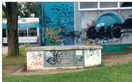
Alles andere als schön: die Schmierereien am Hallenbad und an der Turnhalle in Söhlde.
