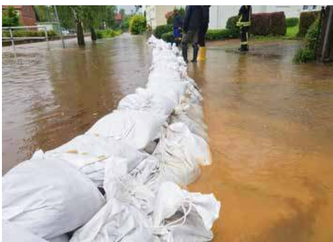
Barriere kurz vor dem überlaufen
