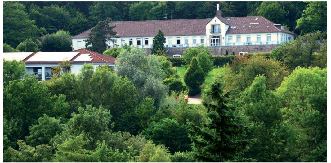
Das Hauptgebäude der ehemaligen „Lungenklinik“ soll erhalten bleiben, daneben werden ca. 100 Wohneinheiten neu entstehen, in herrlicher Südhanglage inmitten eines alten Baumbestandes, um die genaue Gestaltung gibt es noch reichlich Diskussionen
