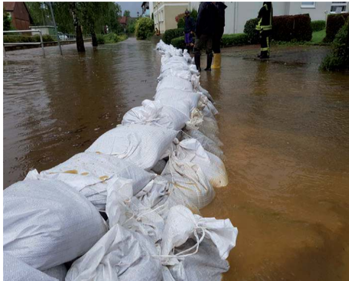
Sandsackbarriere in Diekholzen am alten Weg kurz vor der Überflutung
